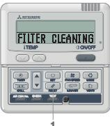
Toplam işlem süresi belirlenen saat ulaşıp temizlik zamanı belirtildiğinde "FILTER CLEANING" ekranına gelir.
